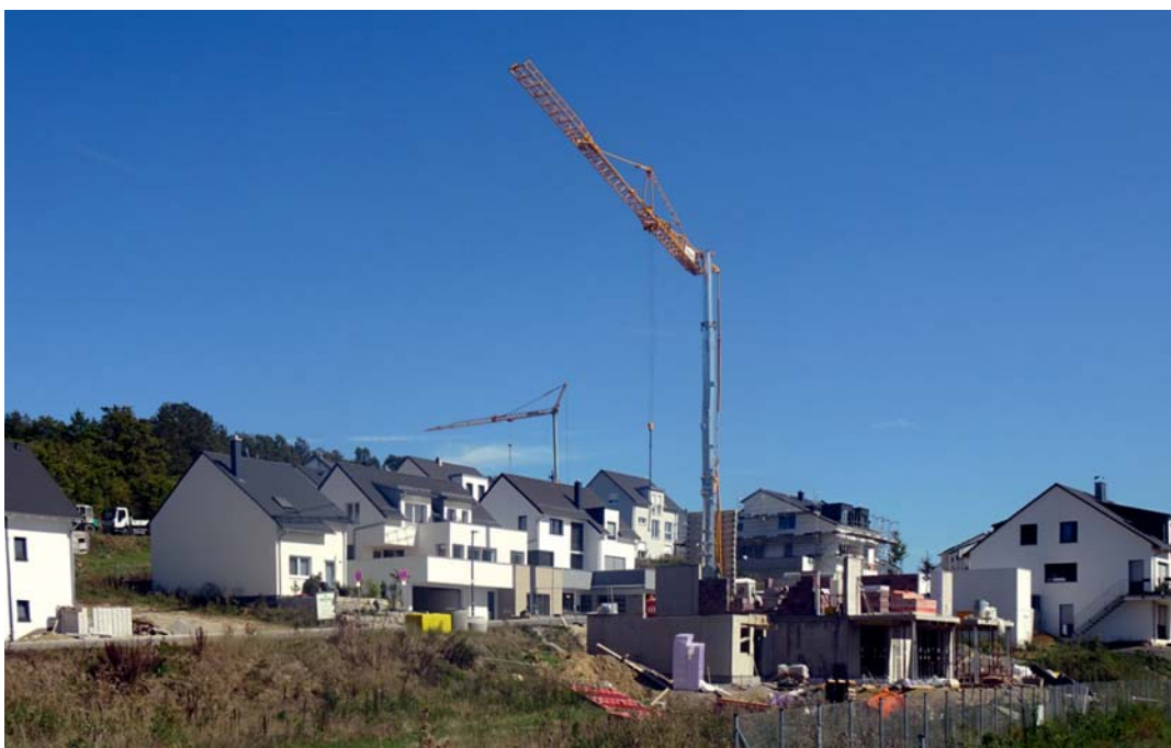
Umsetzung von Bauvorhaben in einem neu erschlossenen Wohngebiet.
